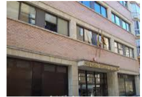
EDIFICIO D.G.A. RICARDO DEL ARCO
